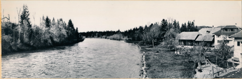
Sicht aareabwärts von der Jabergbrücke bei Q = 179 \text{ m}^3/\text{s}
